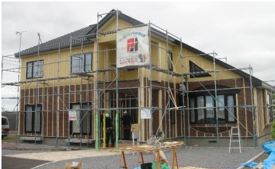
【施工現場全景】
