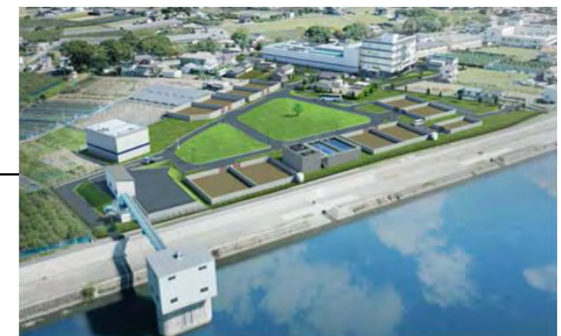
鳴門市・北島町共同浄水場
