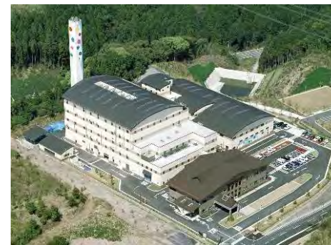
ごみ焼却・溶融プラント
