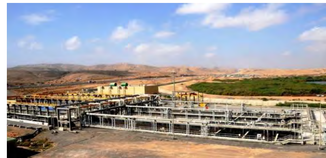
施設名: Al Ansab STP 所在地: オマーン国マスカット市 計画水量: 13万m 3 /日 ※中東地域最大規模 納入時期: 2016年
