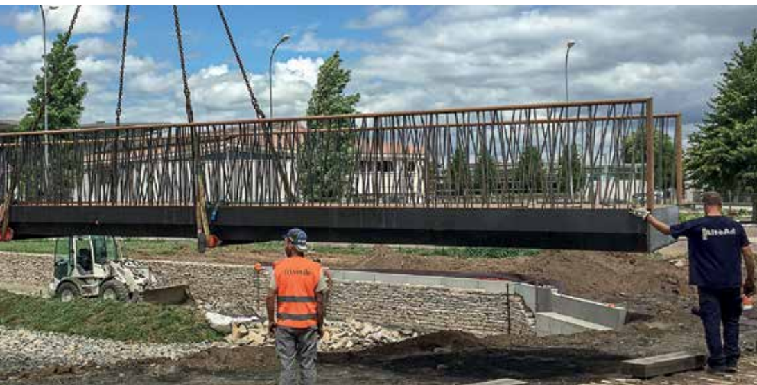
Placement sur site d'une passerelle préfabriquée à Châlon-Sur-Saone, France.
