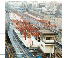
▲工事中の妙典駅（1999年）
