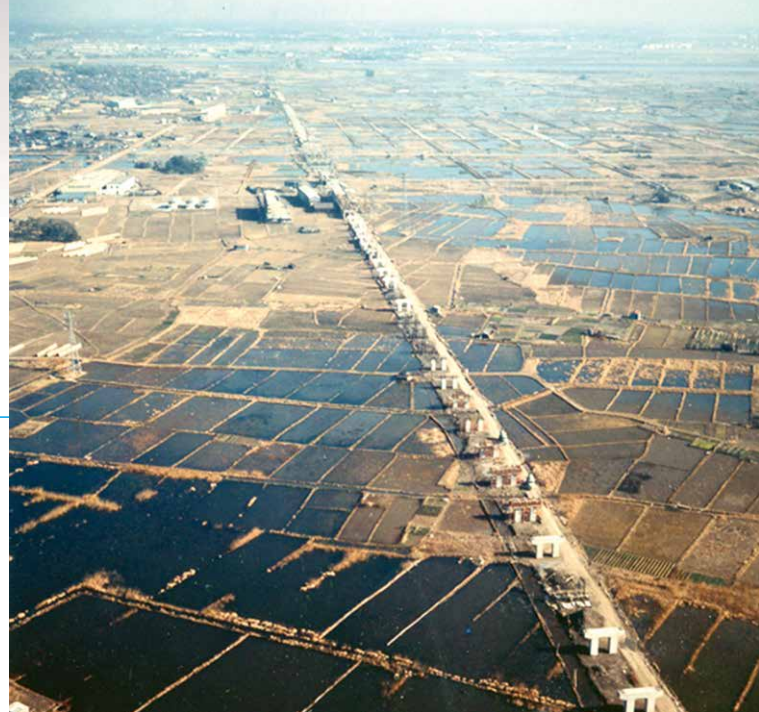
▲建設中の行徳駅付近の様子（1960年代）
