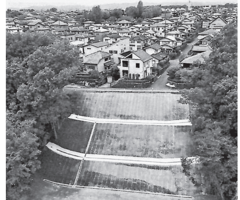
楓ヶ丘3丁目の緑地法面（工事完了）
