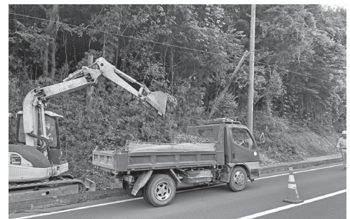
町道第2号線災害復旧工事（施工中）
