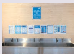
手洗い場を、研究講義棟1階ガレリアに4台（1台3蛇口）、1～3階の各トイレ前に各1台新設
