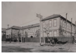
独立当時(1899[明治32]年)、高等商業学校の運動場に建設された校舎(神田錦町3丁目14番地)
