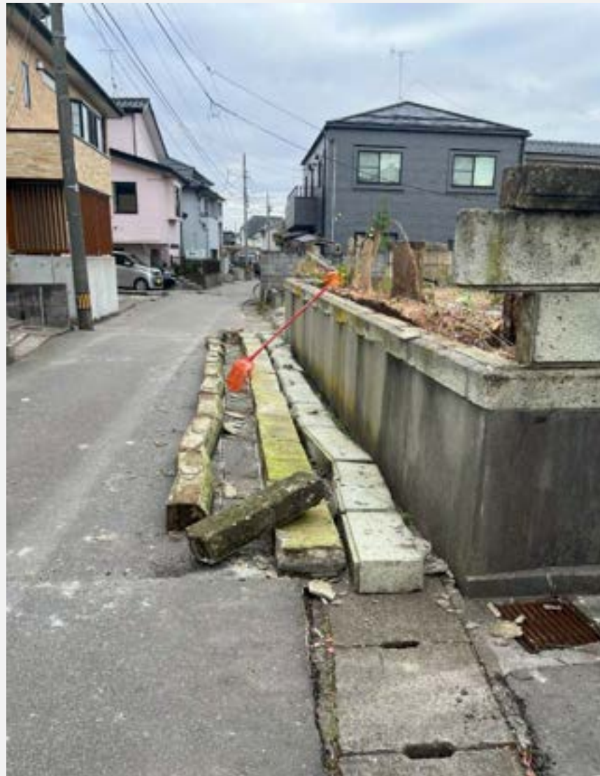
控壁や鉄筋による補強がないブロック塀の転倒
