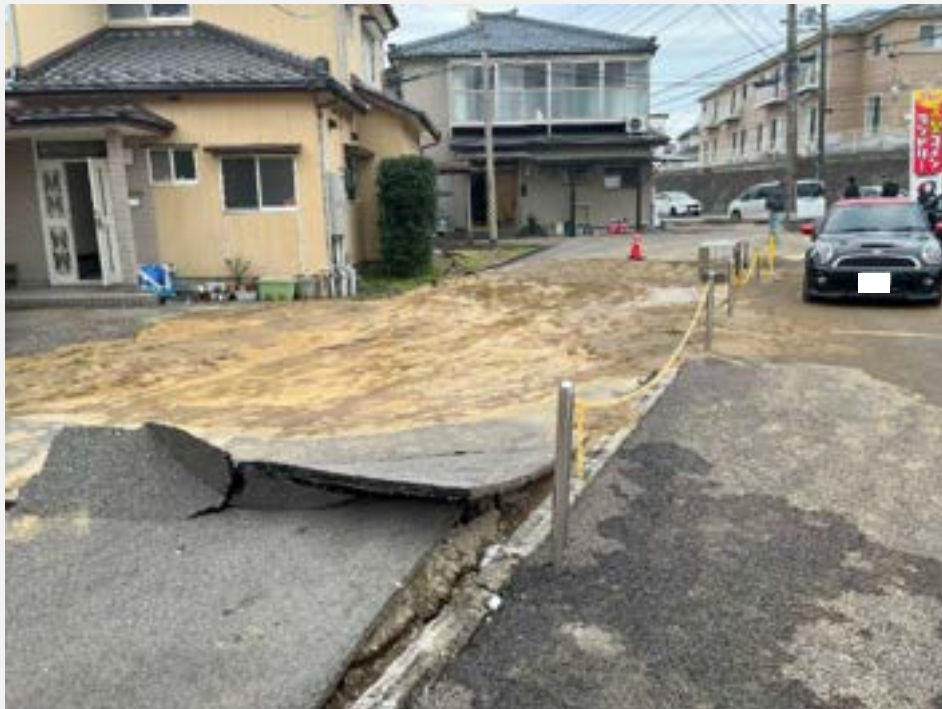
県道16号から南東側の低地に向かって低層住宅・商店の基礎地盤の滑動、および舗装の亀裂・破壊が確認
