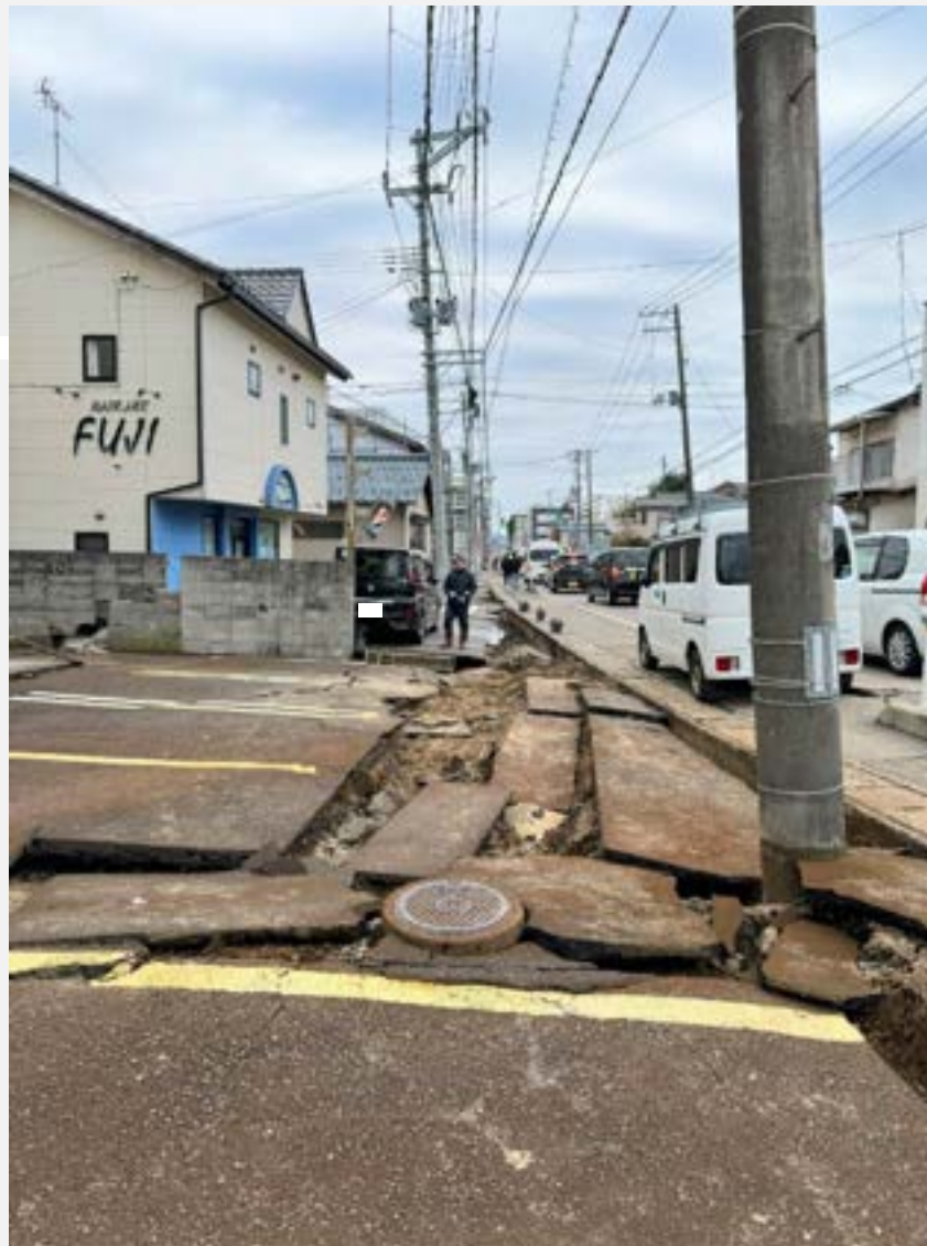
県道16号から南東側の低地に向かって低層住宅・商店の基礎地盤の滑動、および舗装の亀裂・破壊が確認
