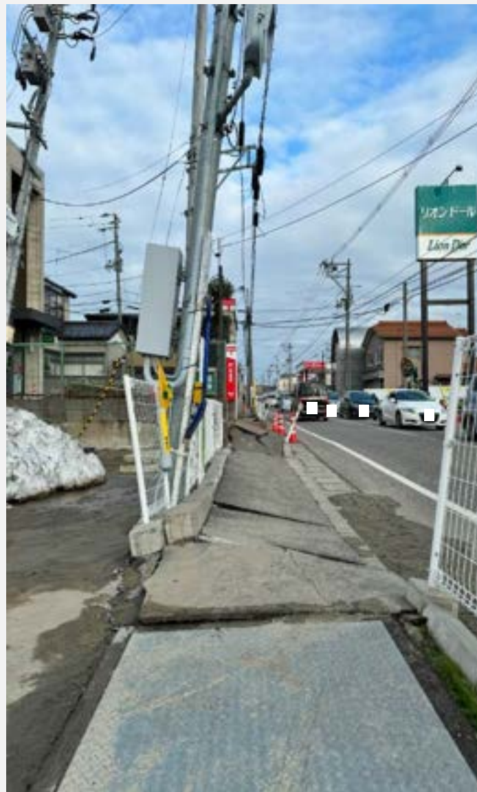
県道16号の北東側 (砂丘高地側)で舗装の圧縮ひび割れや破壊が顕著
