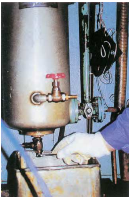
ドレン抜き作業
