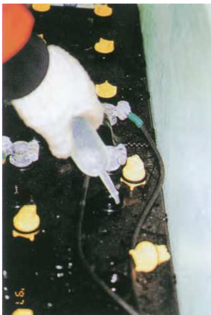
蒸留水補給作業
